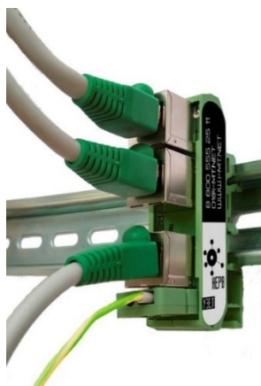
Рисунок 8.1 – Монтаж узла Нерв
